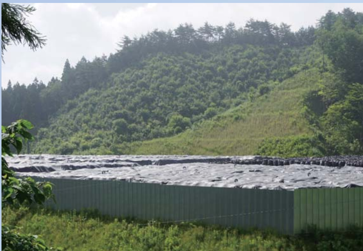
放射能汚染土の仮置き場
